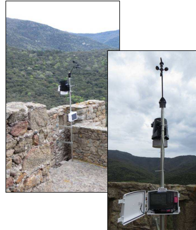
→ Instal·lació d'estació meteorològica al Castell de Requesens (abril 2015)
